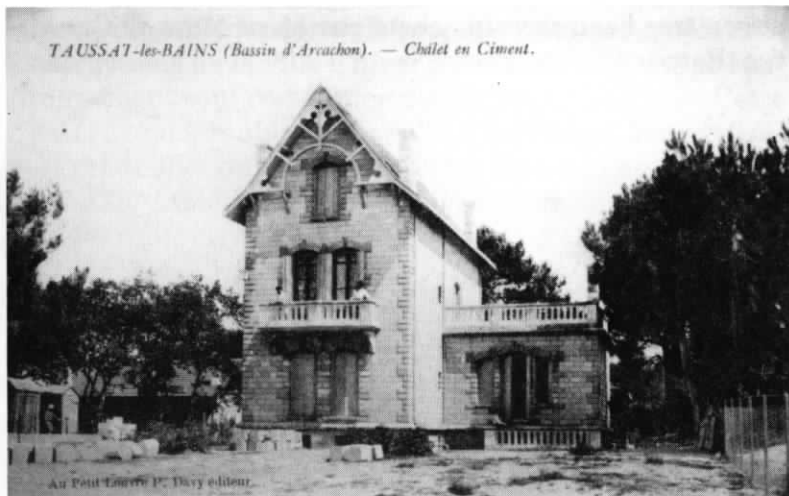
Le chalet en ciment avant ses transformations (actuellement "Tamaris")
